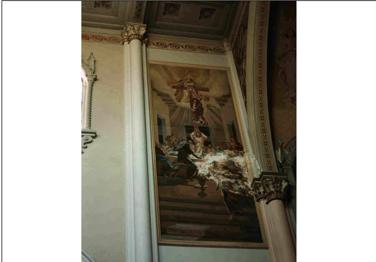
a- Parete Navata Centrale laterale sinistra confinante con l'abside
